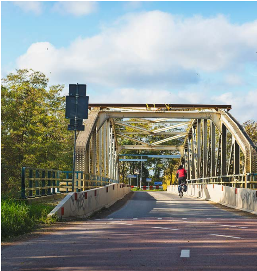
De brug bij Itteren over het Julianakanaal wordt de komende jaren volledig vervangen door een nieuwe brug met ruime vrij liggende fietsvoorzieningen.
